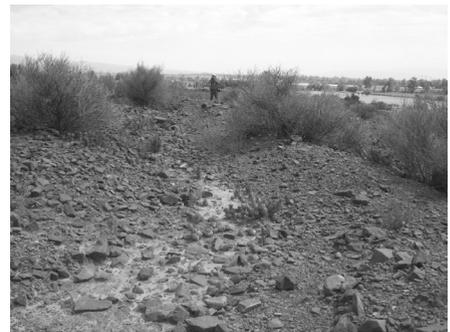
Figura 4: Canal sección trapezoidal atarquinado
