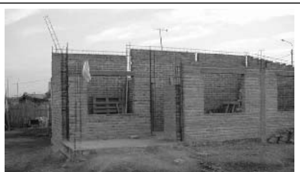
Figura 3. Vivienda definitiva en construcción.
