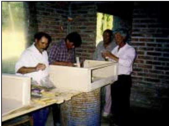
Figura 2: armado de las cajas de aglomerado.
